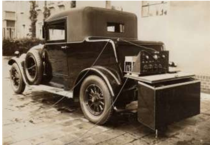
Ingenieurs-Kraftwagen mit Funk Aufnahme von 1931
