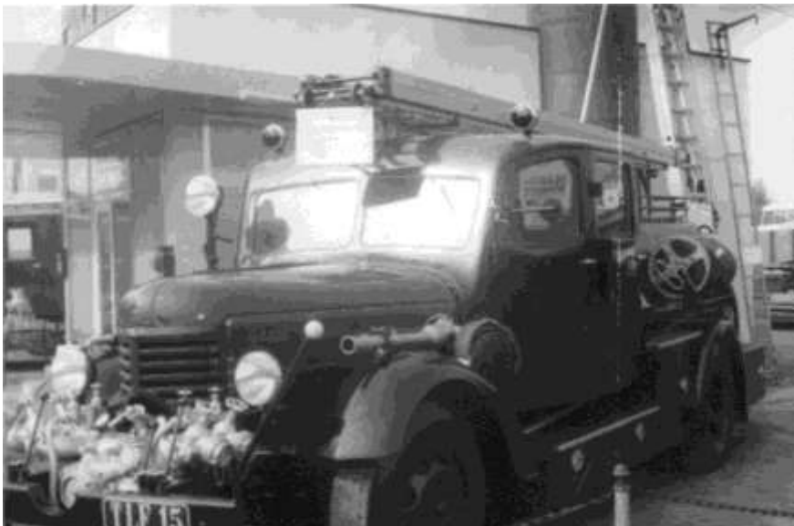
Tanklöschfahrzeug TLF 15 auf ZIS-Fahrgestell
